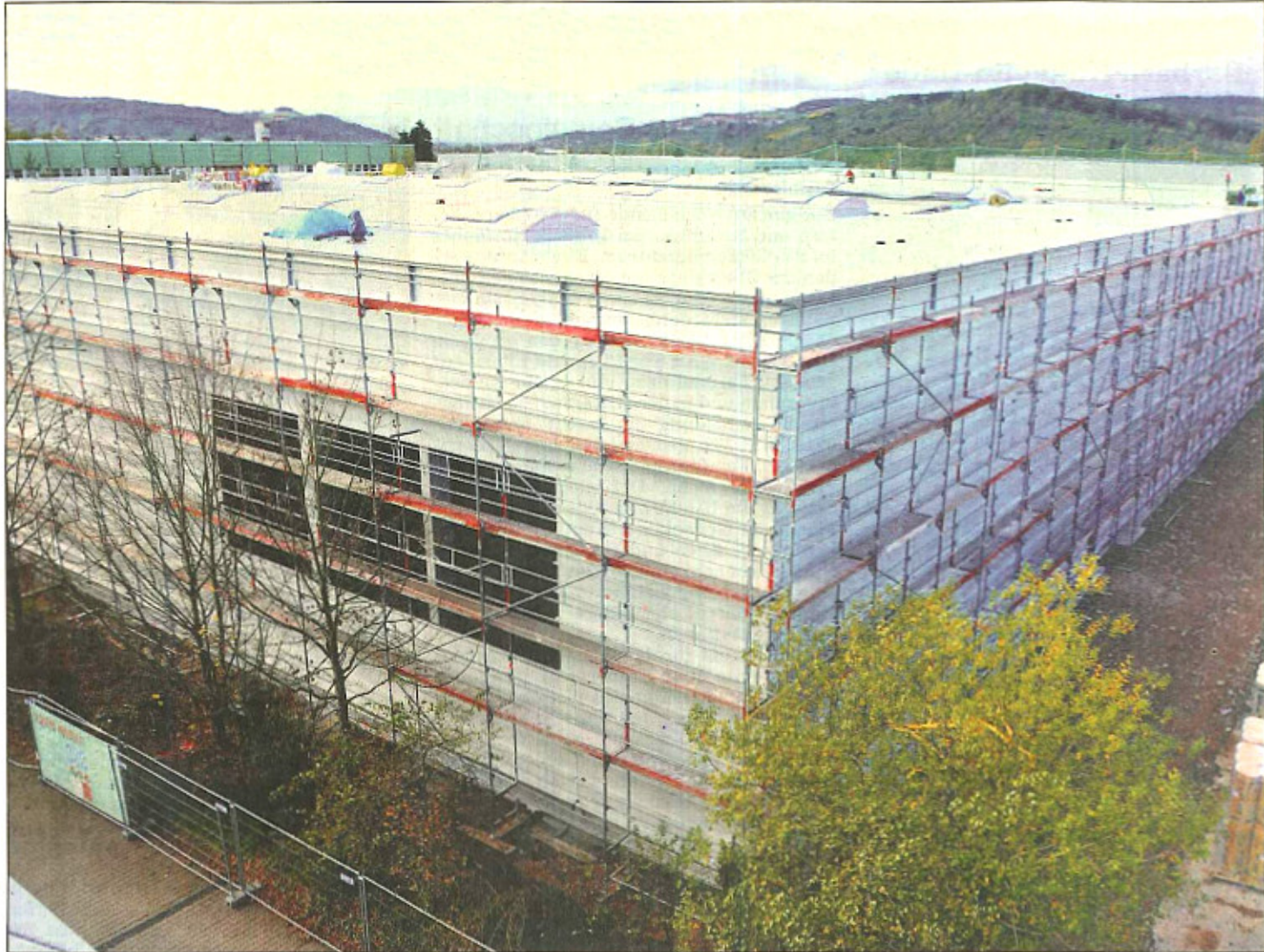
Nach Fertigstellung wird die Firma Mahle Aftermarket die von der Schatz projectplan erstellte Distributionshalle beziehen.
