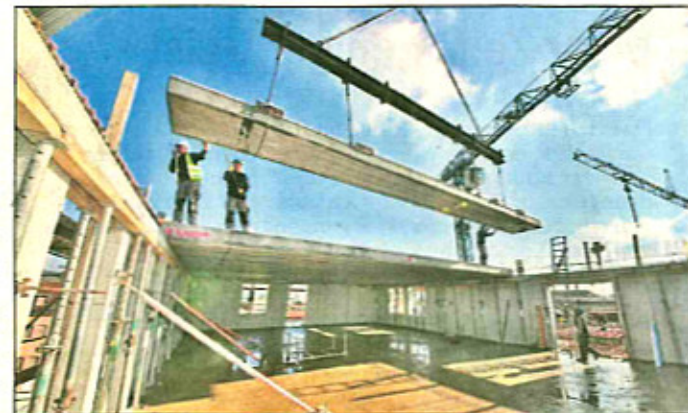
Der Bau war ein aufwendiges Unterfangen.
